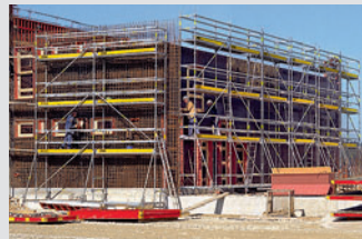
Állványok betonacél szereléshez
