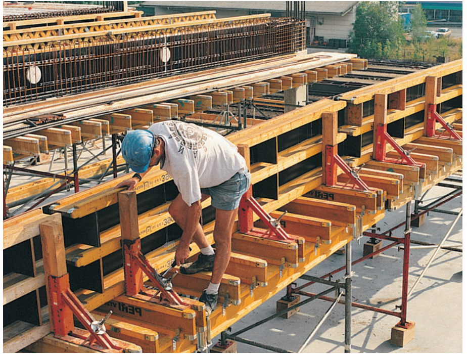
Áthelyezhető PERI UZ egységek előszerelten, egy parkolóház építésénél.
