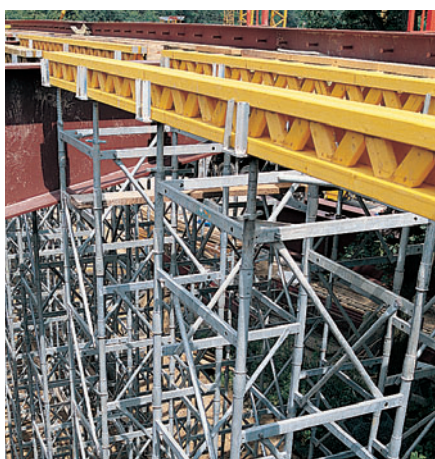
Az ST 100 keresztfejes fejtámaszba két GT 24 billenésbiztosan illeszthető.
