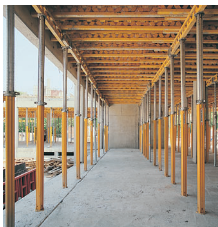
MULTIPROP MP 350 alkalmazása GT 24 fő- és kereszttartóval, MULTIFLEX födémzsaluzatnál.
