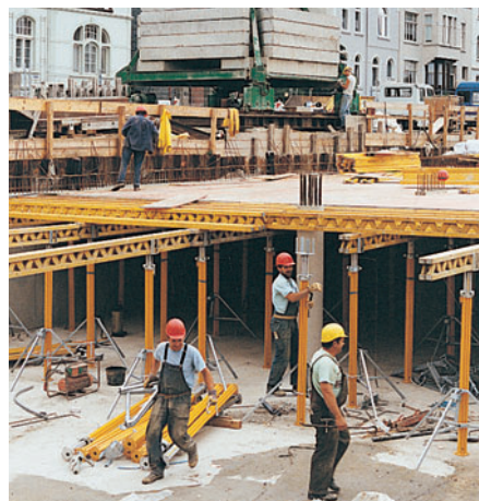
Mélygarázs építése duplázott GT 24 főtartóval. A MULTIPROP támaszok bírják a nagy terhelést. Az eredmény gyors zsaluzás az alacsony elemszám miatt.
