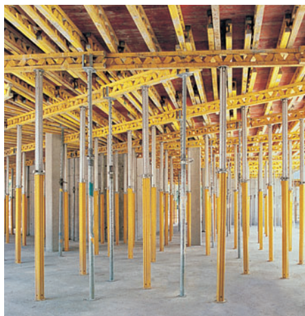
A főtartó irányának változtatása és a keresztartók teleszkópos sorolása a MULTIFLEX födémzsalukat tetszőleges alaprajzhoz illeszthetővé teszi.
