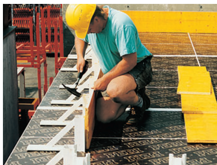
Az oldalrögzítő tám SKYDECK esetében is közvetlenül a zsaluhéjra szegezhető, bármely irányban.
