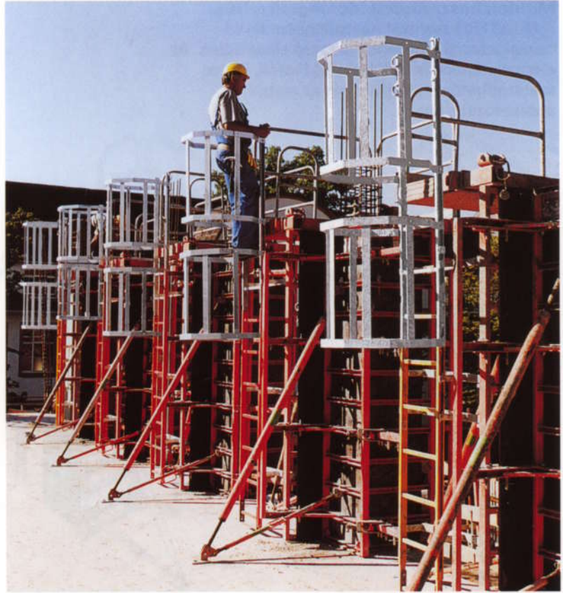
Létrák a betonozó állvány biztonságos eléréséhez.
